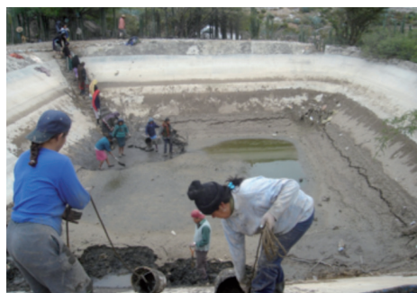
Figura 5. Las mujeres de La Pastilla sacando el azolve de las hoyas.
