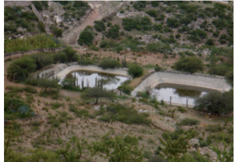
Figura 8. Las obras concluidas al final del proceso.
