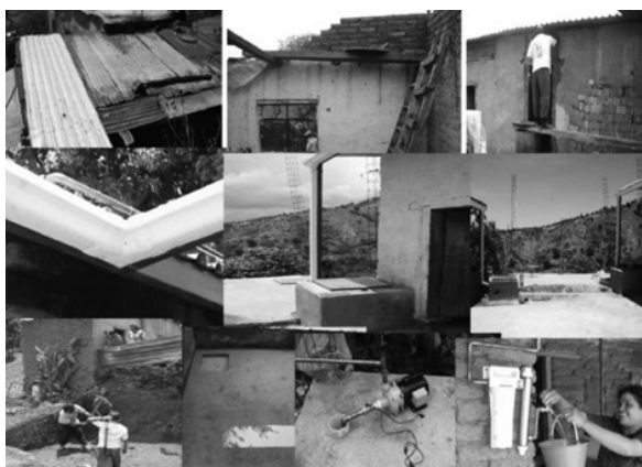
Figura 5. Construcción de sistemas de captación de agua de lluvia en una pequeña comunidad del estado de Guanajuato (Gay Alaniz, 2008)
